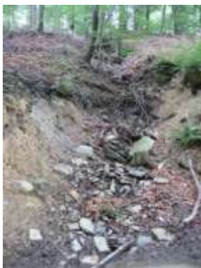
Figure 3. Dans le versant droit, une des ravines dont les flancs montrent une coupe dans la couverture limono-caillouteuse. Le lit mineur est encombré de blocs que le ruisseau sporadique ne peut transporter que difficilement.
